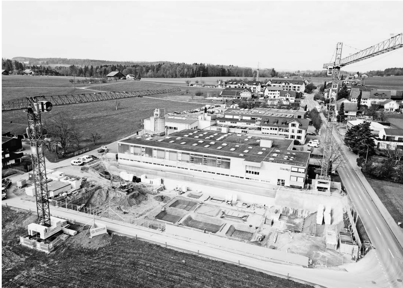
Luftaufnahme der Baustelle zum Erweiterungsbau Werk VI.
